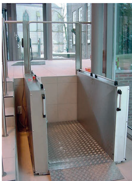
Pystysuoraan nostava Herkules-tasonostin.
